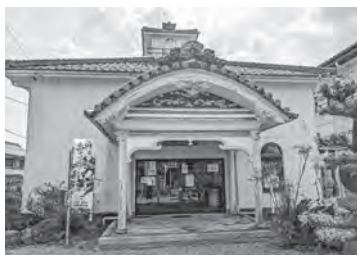
▲菁莪記念館玄関ポーチ
