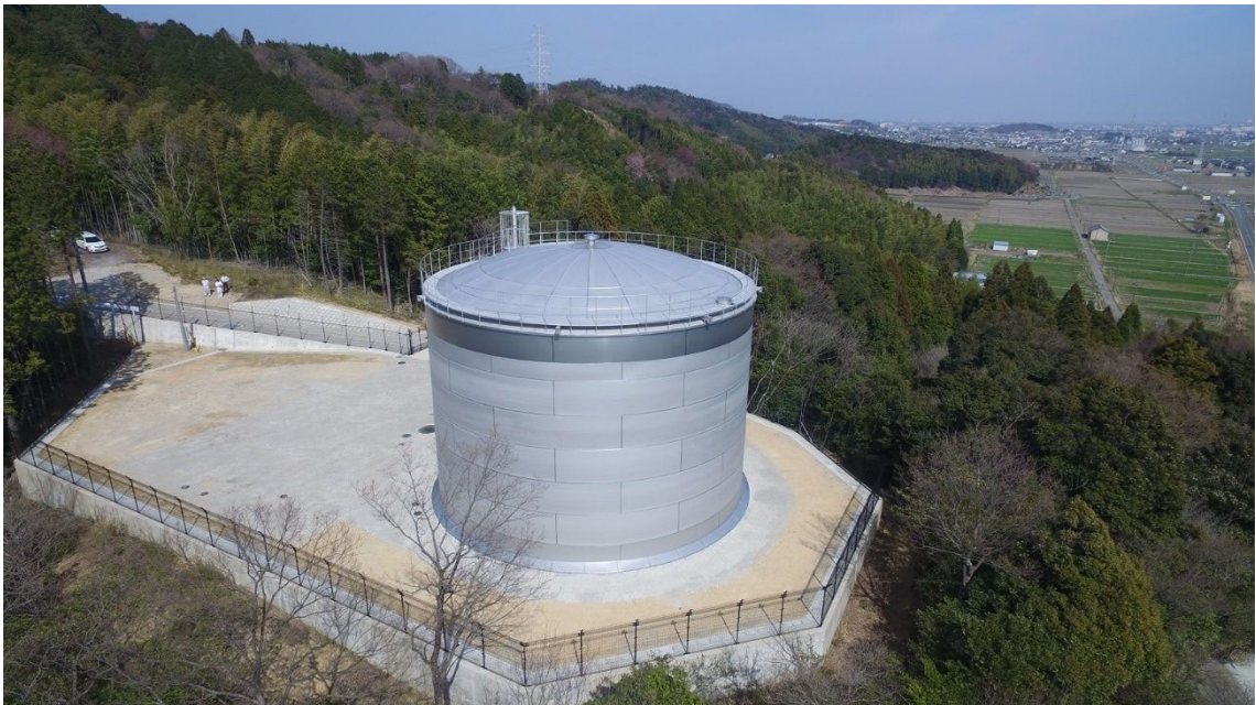
【相川左岸低区配水池】
