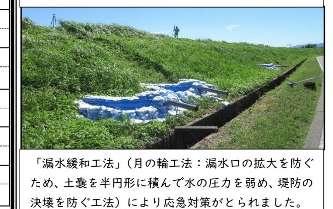
「漏水緩和工法」(月の輪工法：漏水口の拡大を防ぐため、土嚢を半円形に積んで水の圧力を弱め、堤防の決壊を防ぐ工法)により応急対策がとされました。
