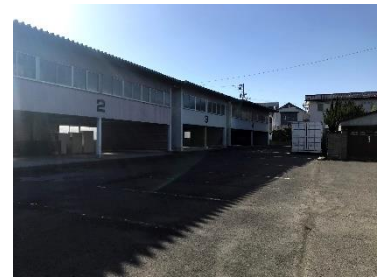
No3, 4, 5. 倉庫 2・3・4
