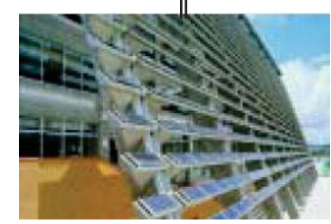
ソーラーパネルと一体化した日よけルーバーのイメージ【糸満市庁舎】
